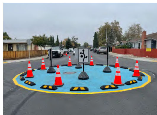
RAPID BUILD MINI ROUNDABOUT
